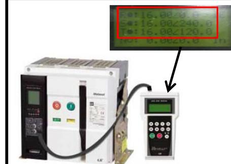
5. Выключатель должен отключиться, контакт AL замкнуться, MRB сигнализирует о срабатывании
